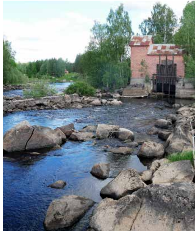
Kraftverksbyggnaden i Söräng som enligt planerna ska rivas. Foto: Anders Bruks.
