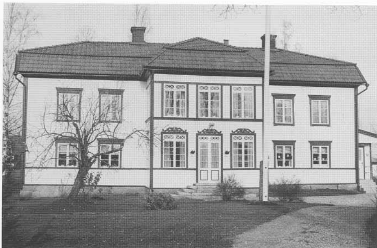
Södra fasaden på gården Tures, trapphuset tillbyggdes vid sekelskiftet år 1900. Takkonstruktionen är karaktäristisk, bruten med valmade gavelspetsar.
