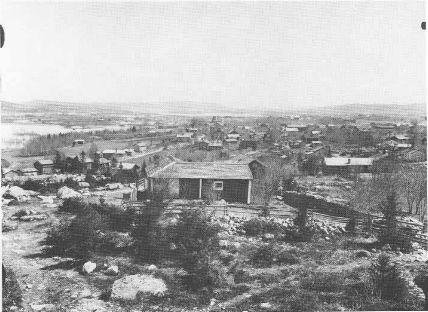
Vy över Borgen mot söder. Foto från slutet av 1890-talet.
